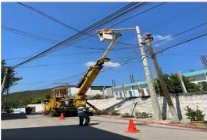
Además, se realizó la mejora en los servicios básicos, tal como el proyecto de mantenimiento de las instalaciones eléctricas de potencias en el Centro Universitario de El Progreso, el cual consistió en implementar un nuevo sistema de potencia integrado por un nuevo transformador, postes, cableado, tableros e interruptores nuevos.
